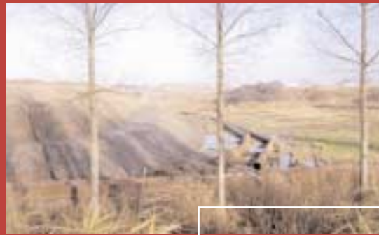
Aanleg van zandstock
