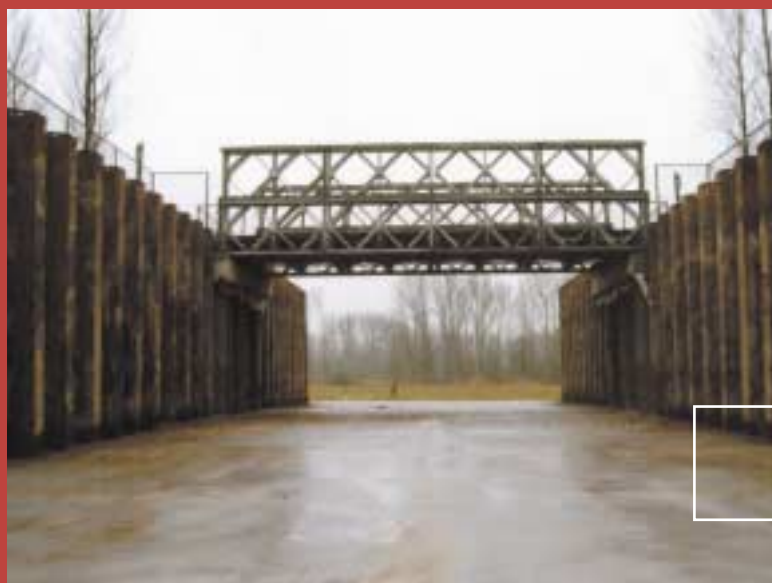
Afgewerkte Baileybrug
