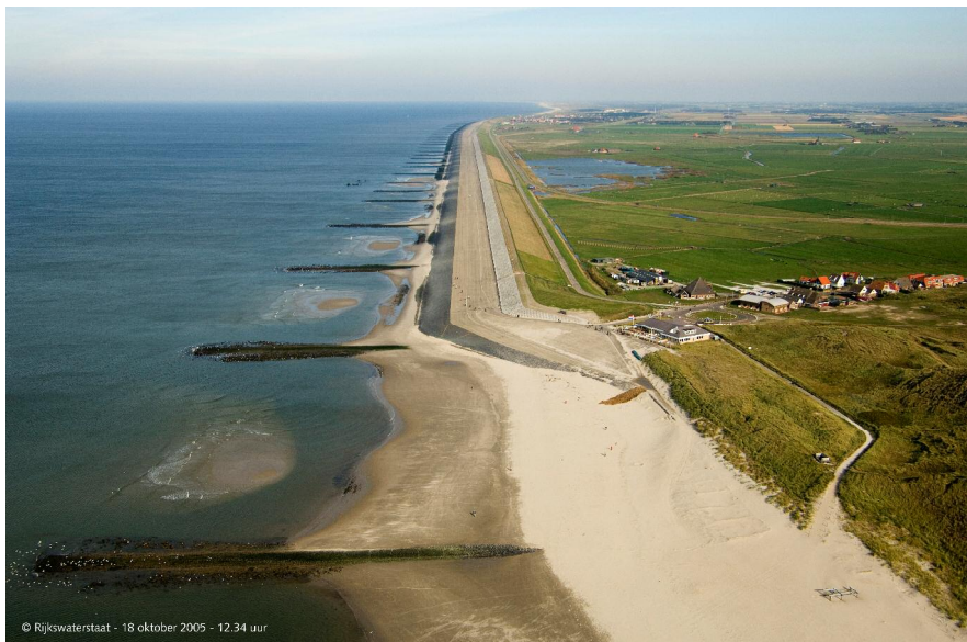
Foto 1.1. Luchtfoto Hondsbossche en Pettemer Zeewering (vanaf Camperduin)
