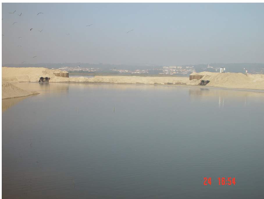
Fig. 3 Embocadura da Barrinha, com o dique fusível colocado. (Foto de António Mota Lopes)
