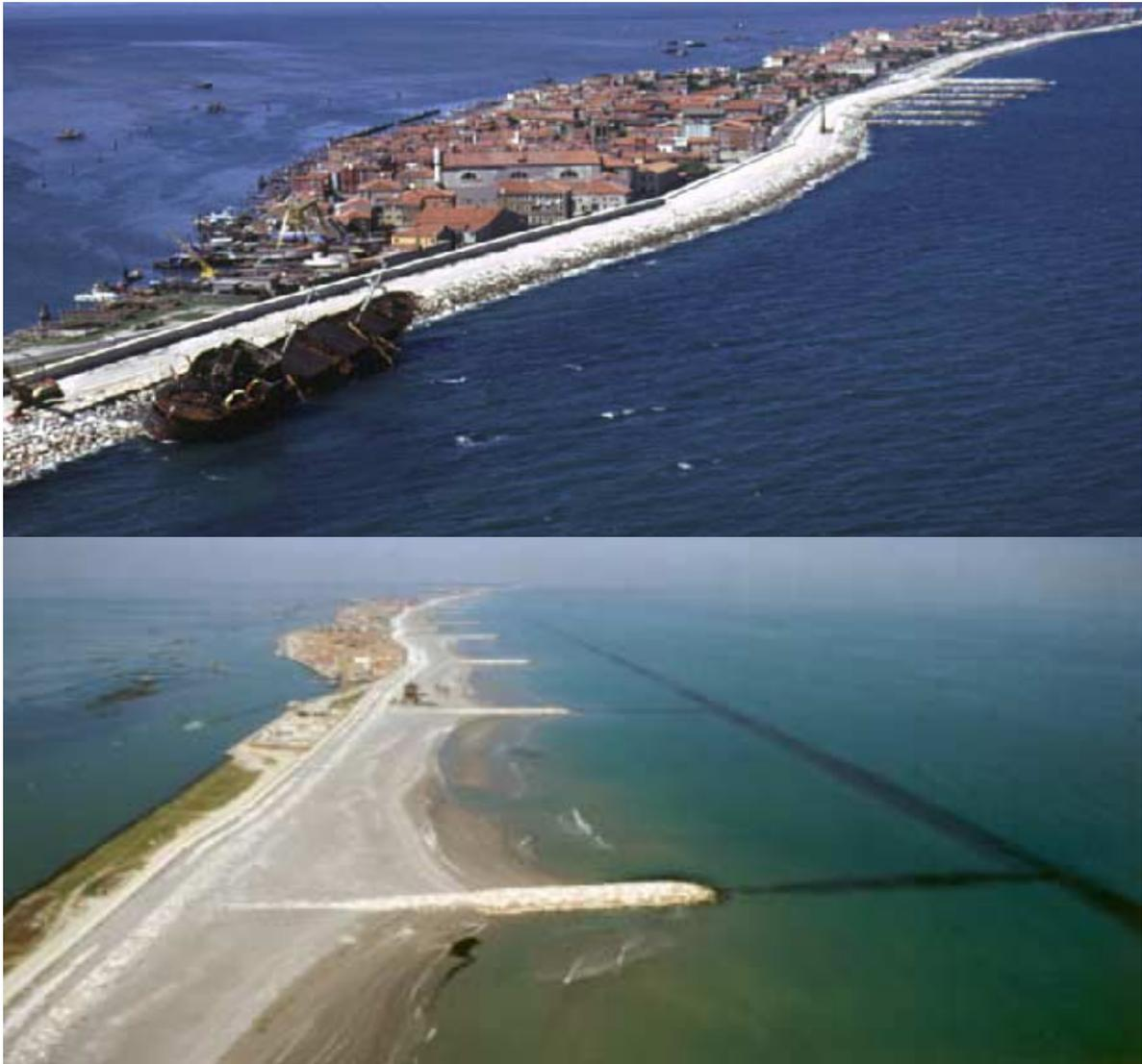
**Figura 1. Ripascimento protetto del litorale di Pellestrina: prima dell'intervento (sopra) e dopo la realizzazione della spiaggia protetta da pennelli e da una barriera sommersa (sotto).**
